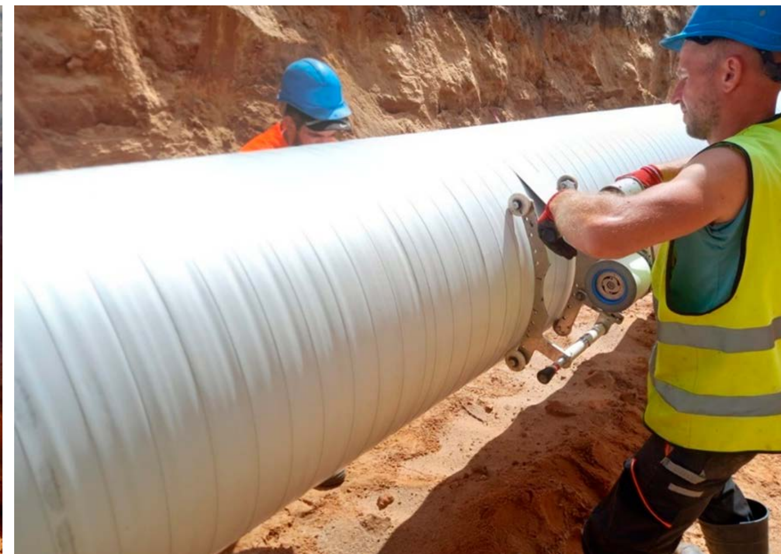
12. attēls. Cauruļvada pārīzolācijas process. Vecās izolācijas noņemšana. Jaunās izolācijas uzklāšana
