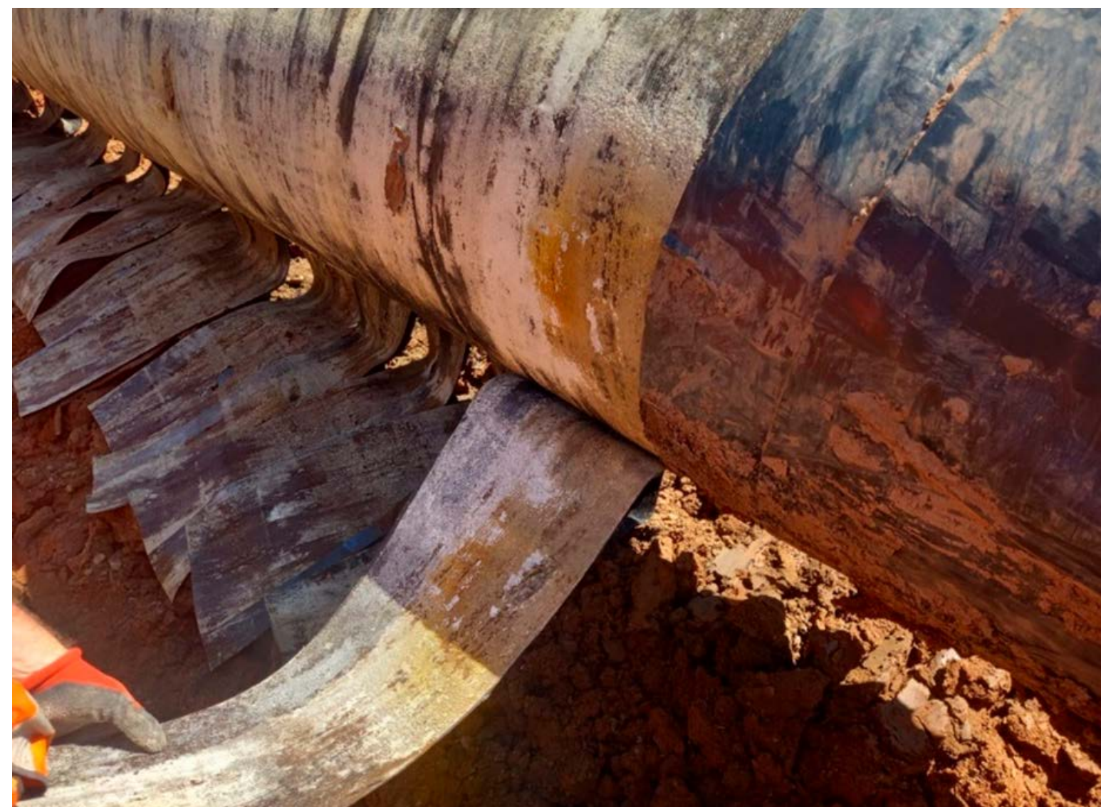
12. attēls. Cauruļvada pārīzolācijas process. Vecās izolācijas noņemšana. Jaunās izolācijas uzklāšana
